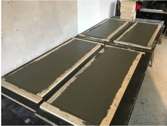
Abbildung 6 gefüllte Form (Innenwand)
