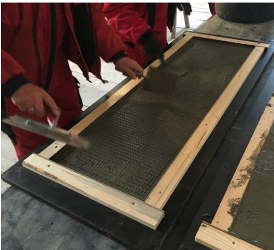
Abbildung 5 Carbonbewehrung einsetzen
