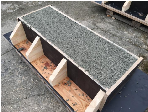
Abbildung 8 gefüllte Form (Außenwand)
