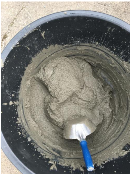
Abbildung 3 Mischung einschichtige Innenwandlösung
